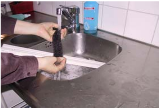
3. Raitisilmaventtiilin sisällä on suodatin, jonka voi pestä vedellä ja astianpesuaineella.
