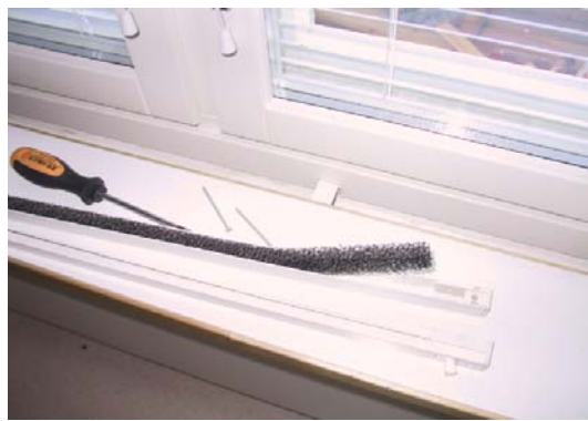
4. Kokoa puhdistetut osat paikoilleen. Huomaa, että ilman pitää suuntautua ylöspäin. Näin ei synny vedontunnetta auki olevasta venttiilistä. Puhdista raitisilmaventtiili kaksi kertaa vuodessa, keväällä ja syksyllä.
